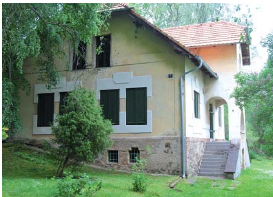
Das ehemalige Bürgermeisteramt steht als einziges Gebäude noch.
