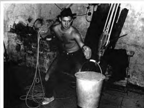
Bau eines Fluchttunnels in Berlin
